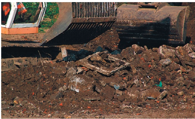
Foto van het saneringswerk van het stort Scheurbroek
