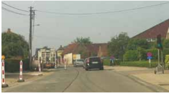
Wegenwerken in de Rooigemstraat (een omleidingstracé voor de werken aan de N42) gebeurden gelijktijdig met de werken aan de N42.
